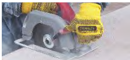
Fig. 14 Corte de Hebel® Power Panel.
