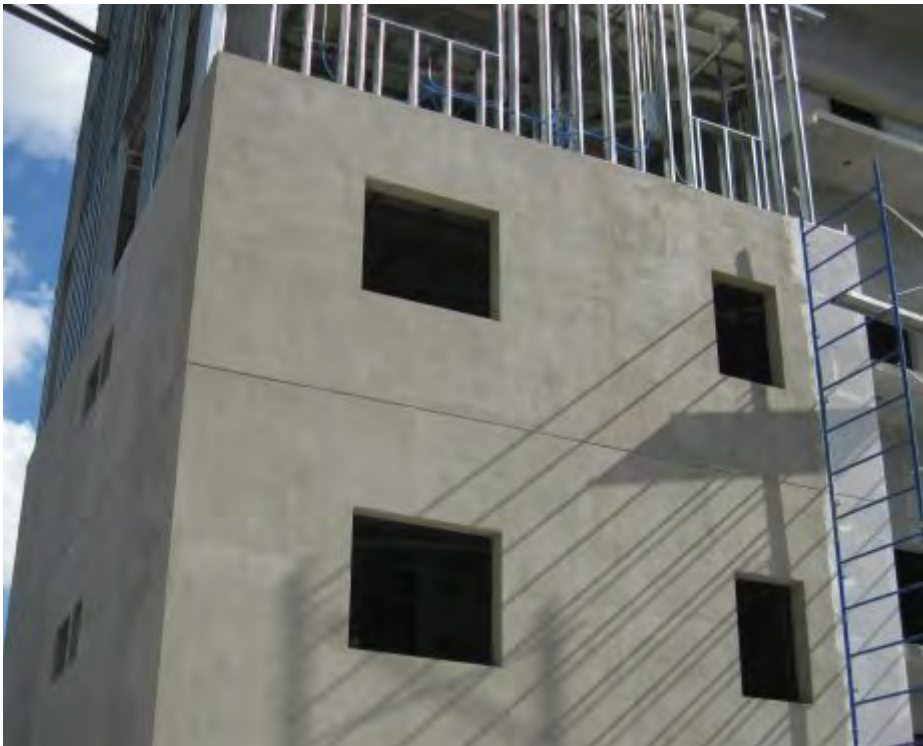
Fig. 19 Tablero de Hebel® Power Panel con acabado.
