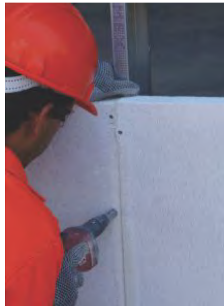
Fig. 11 Colocación de tornillos en unión.
