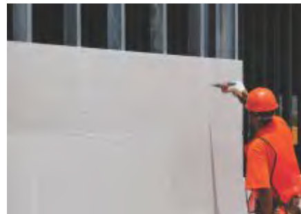
Fig. 13 Instalación de hiladas superiores.
