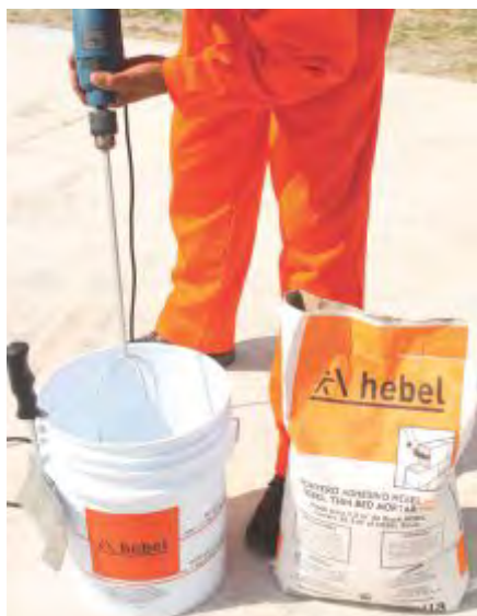
Fig. 7 Preparación de Adhesivo Hebel®.
