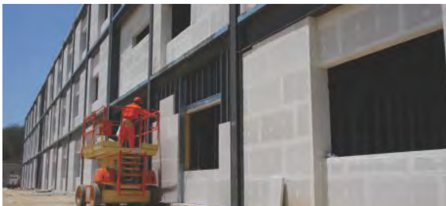
Fig. 18 Tablero de Hebel® Power Panel instalado.
