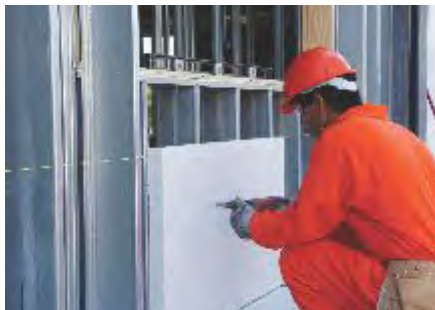
Fig. 9 Instalación de primera pieza.
