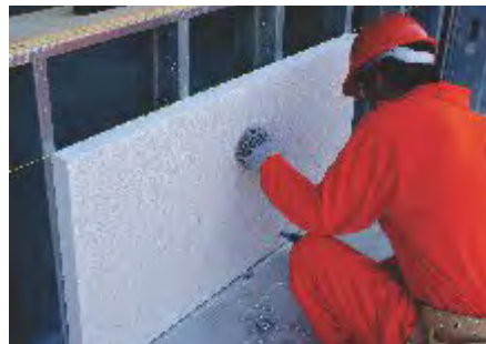
Fig. 10 Atornillado en postes centrales.
